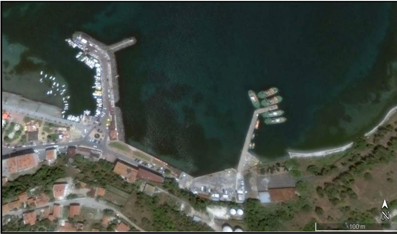
Şekil 2. Marmara Ereğlisi Balıkçı Barınağı (www.google.earth)
